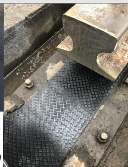
Las almohadillas DORANCE GSR han sido especialmente diseñadas para el mejorar el desempeño de los rieles de grúa, se montan de forma continua en acero, o en concreto mezclado y acero, junto con clips de fijación GSR. Las almohadillas PAD DORANCE GSR se fabrican como una tira de elastómero sintético vulcanizado, reforzado con una tira de acero en medio
